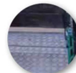
Bandella mobile che raccorda al piano
